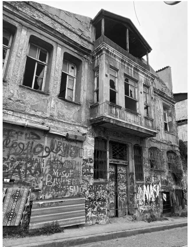
Resim 5: Balat'ta atıl durumdaki bir yapının giderek yok oluşu (Yazarın Arşivi)
