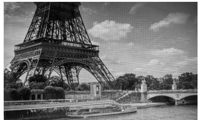
Şekil 1. Eyfel Kulesi ve Palais de Chaillou aksında yer alan Léna Köprüsü'nün güney kıyıya bağlandığı bölüm.
